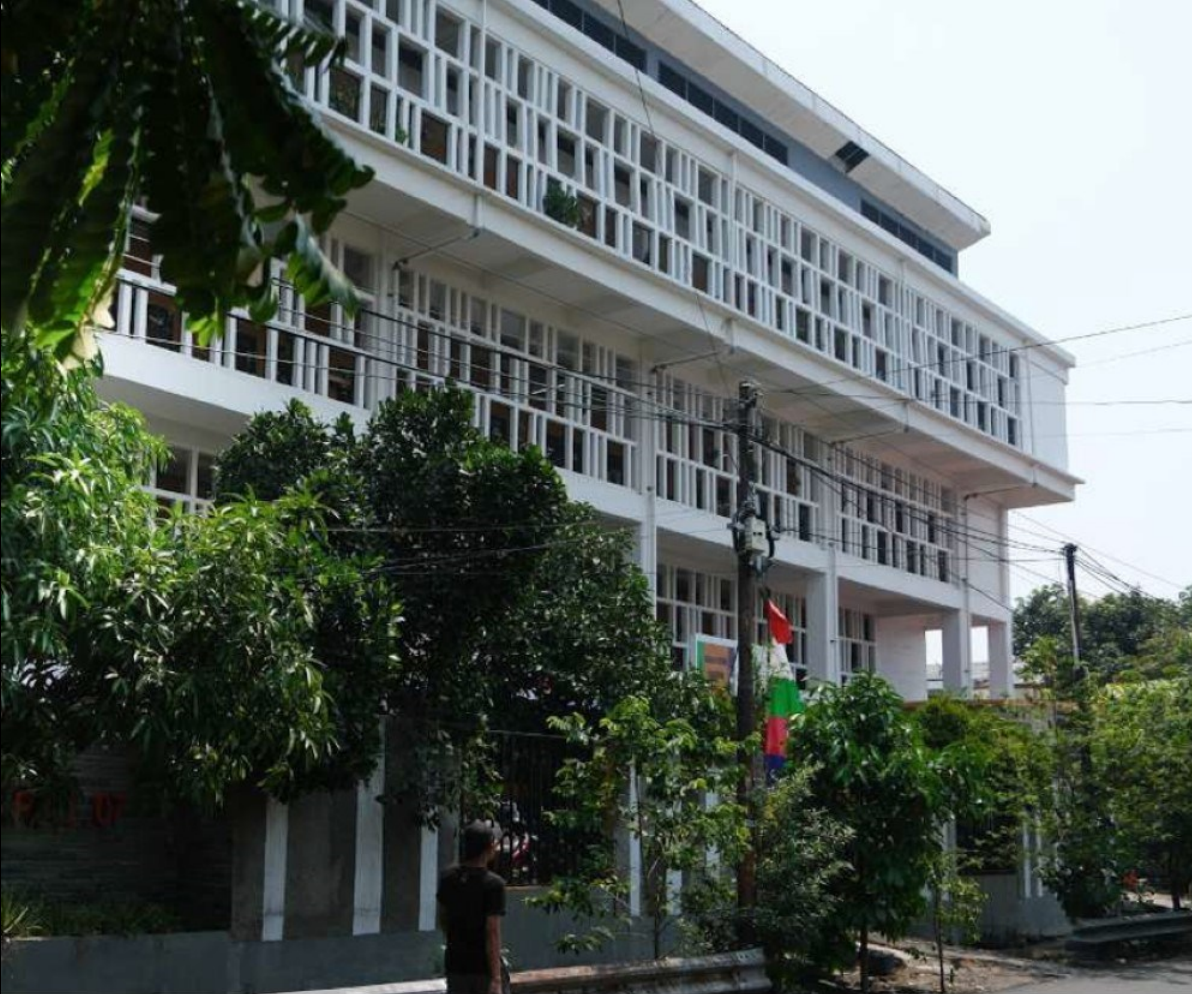
1. Struktur Rangka Kolom + Balok Pracetak
