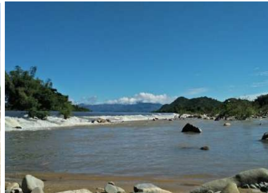
Đập Nha Trinh (Ninh Thuận)
