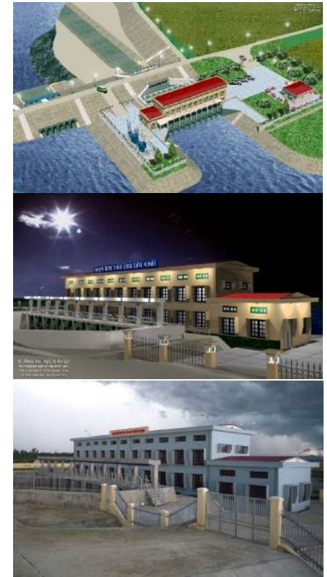
Trạm bơm Cầu Khái (Thanh Hóa)
