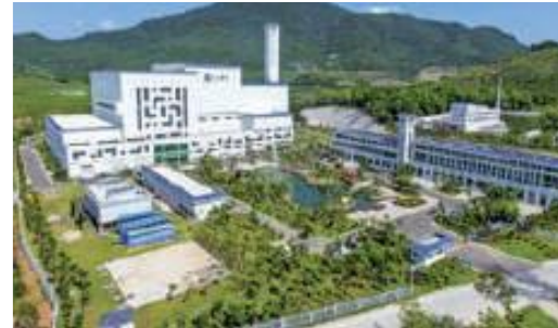
三亚垃圾焚烧发电项目 (一三四期) Sanya Waste Incineration Power Generation Project
