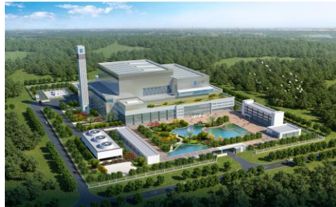
东方垃圾焚烧发电项目 Dongfang Waste Incineration Power Generation Project
