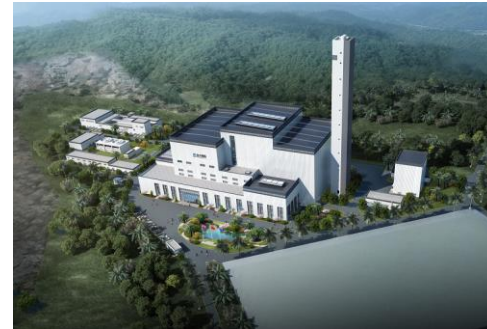
屯昌垃圾焚烧发电项目 Tunchang Waste Incineration Power Generation Project
