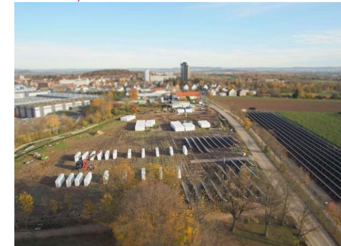
7 солнечных ТЭЦ, общей мощностью 26,6 МВт., Германия 2019 г.
