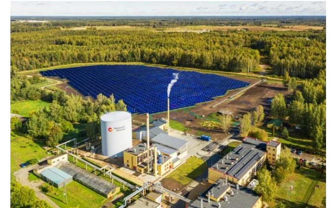
Солнечная ТЭЦ, мощностью 15 МВт., Латвия, 2019 г.
