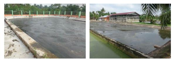
a) Anaerobic Pond
