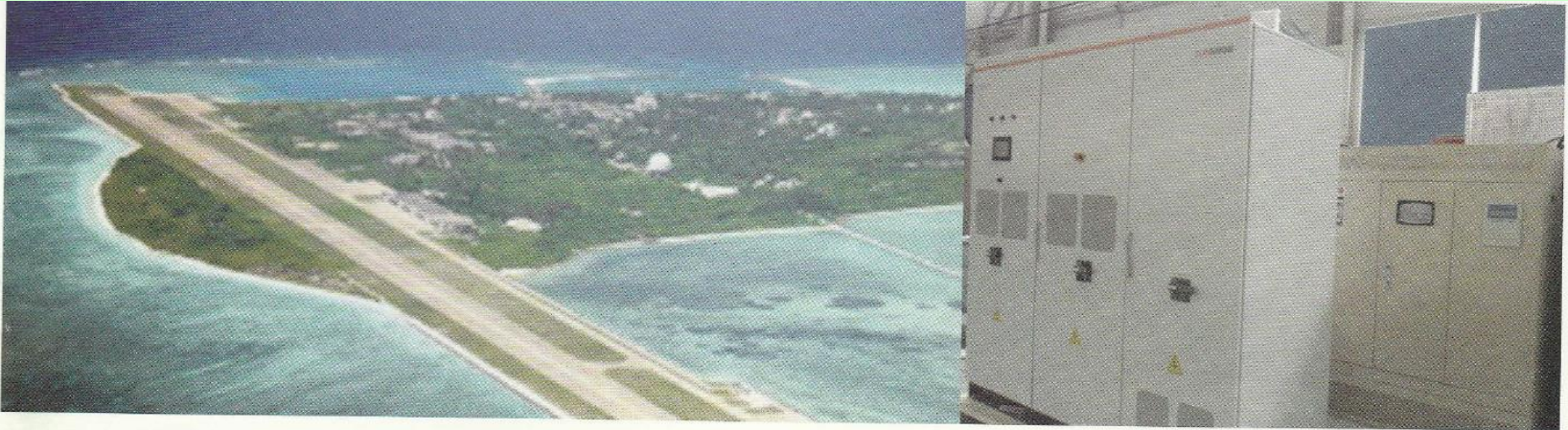
三沙市永兴岛0.5MW独立光伏微电网发电示范项目（2013年）
