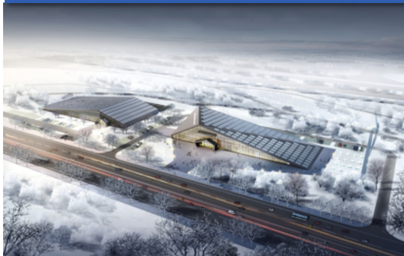
总部经济园能源站
