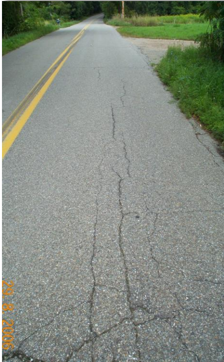
Longitudinal cracking
