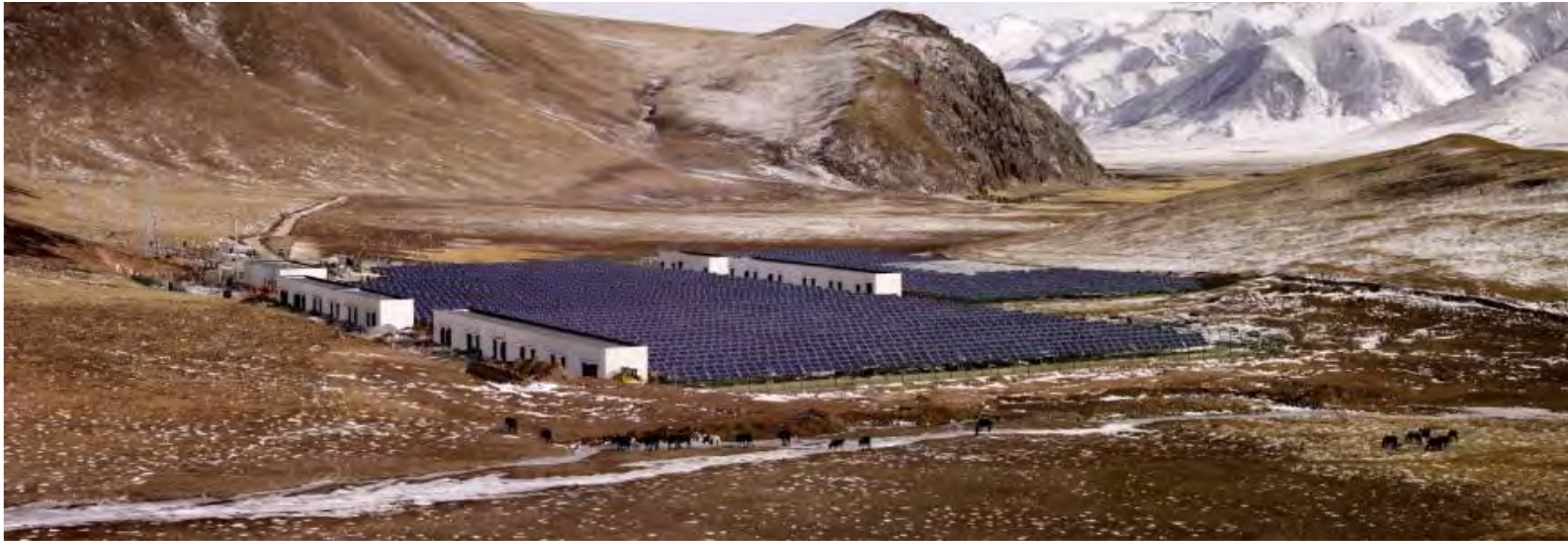
青海玉树光伏/储能电站（2011年建成）
